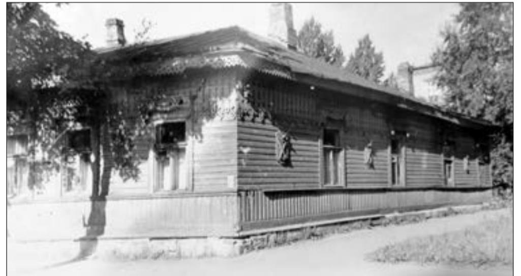
Дом «с пушками» на углу ул. 7-й Армии и Киргетова. Снесен в конце 80-х. Сейчас на этом месте долгострой. Фото Юрия Алексеевича Прокошева.
